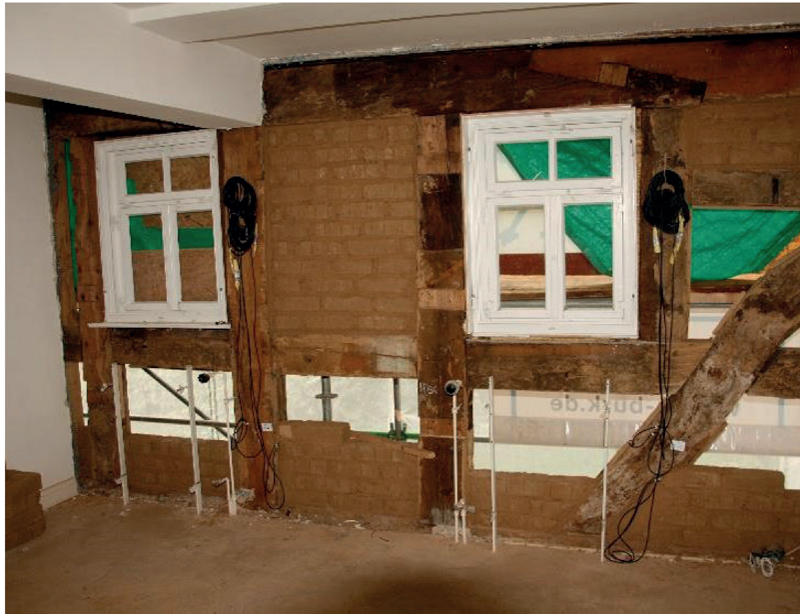
Erfassung des bauphysikalischen Verhaltens
