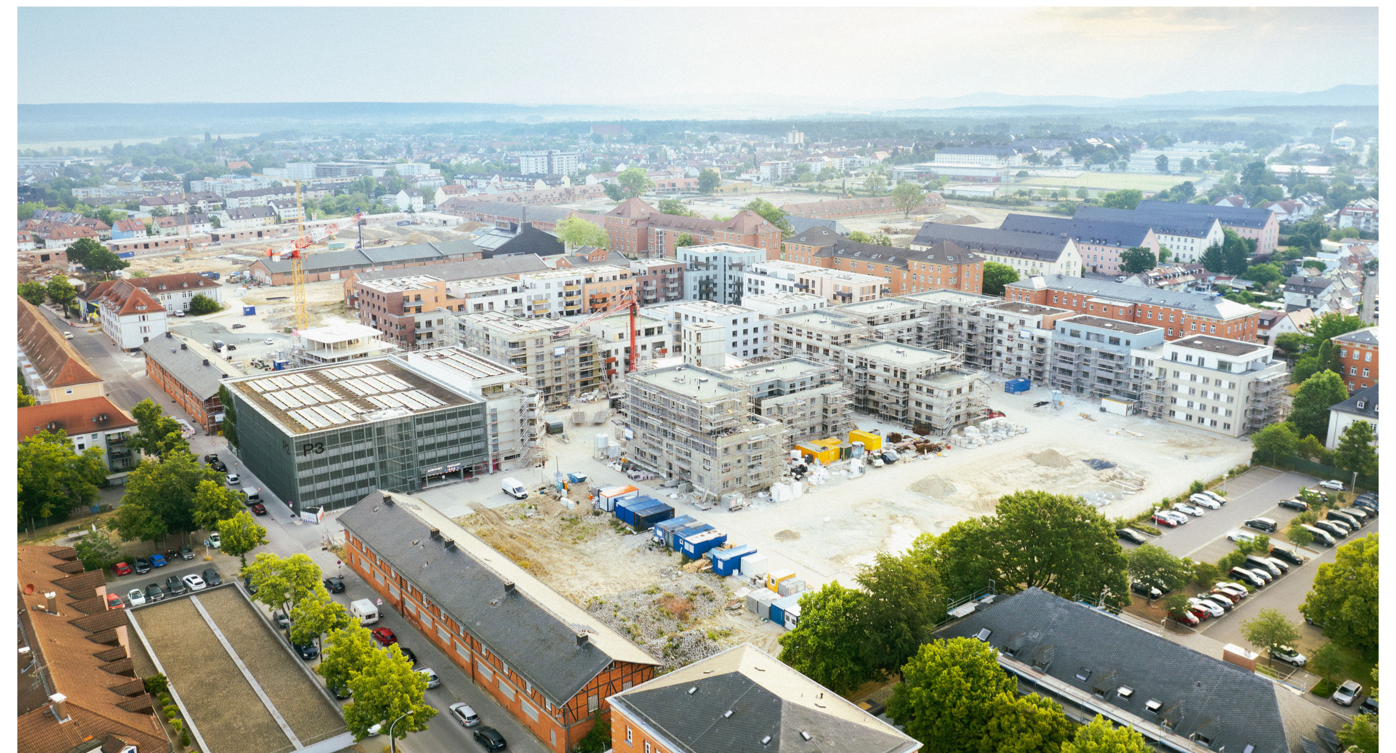
Konversionsgebiet Lagarde in Bamberg: Baufortschritt Campus-West (Quelle: STW Bamberg)
