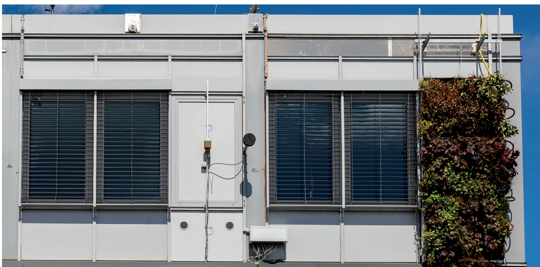
Abb. 89 Außenansicht des Messaufbaus an der Fassade. (IBP)
