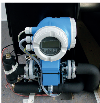
Abb. A15 Durchflussmessgerät, Vorlauf- / Rücklauf-temperatur (THN-AR)
