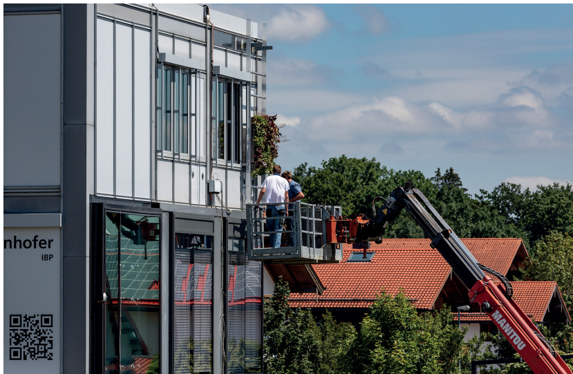
Abb. 78 Anbringen des Begrünungssystems von Verticalgreendesign (VGD) (07.08.2020) (IBP)
