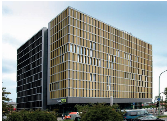
Abb. 2 München, Bürogebäude/ Laimer Würfel (2007); plan2 Architekten, München (TROX 3/2019)
