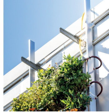
Abb. 85 Wasseranschluss über das Dach (IBP)
