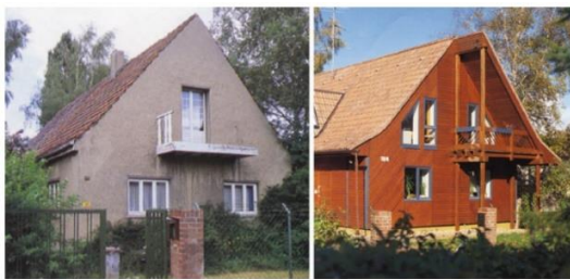
Abbildung 75: Wohnhaus vor und nach der Sanierung mit hinterlüfteter Vorhangfassade aus Holz [30]
