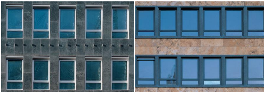
Abbildung 76: Vorgehängte Steinfassaden aus grünem Dolomit (links) und gelbem Travertin (rechts) [31]
