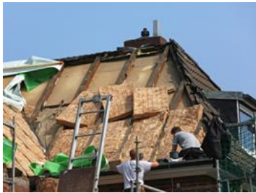
Abbildung 78: Dachsanierung eines Altbaus mit Zwischen- und Aufsparrendämmung [33]
