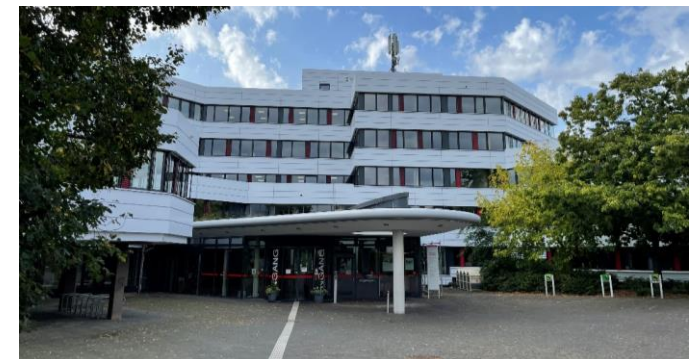
Kreishaus Lippe Haupteingang – sanierten Zustand
