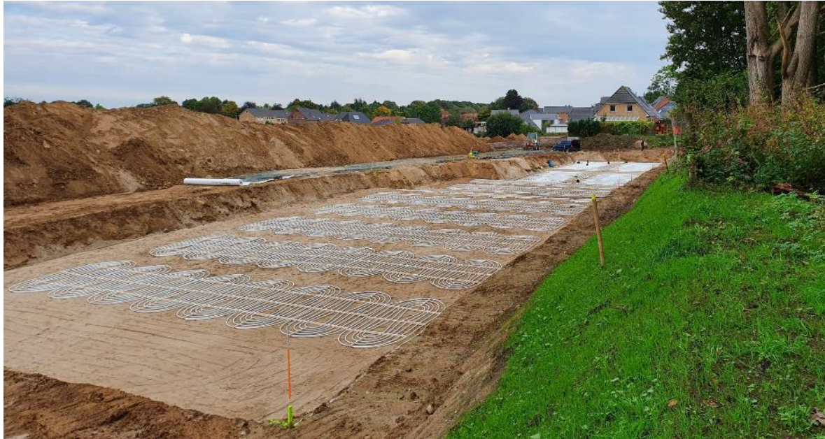
Einbau einlagiger Kollektor und Erdeisspeicher unter der Freifläche (September 2020)
