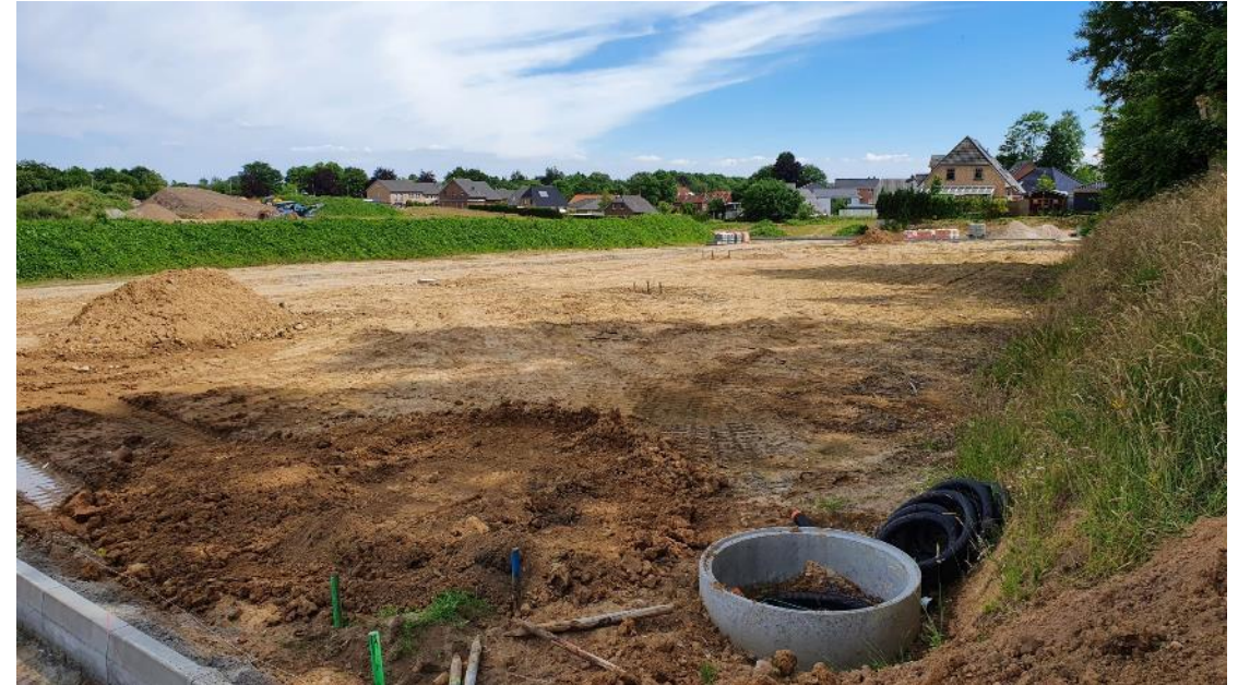
Besichtigung des Baugebietes (Juni 2021)
