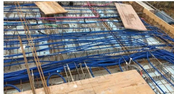
Verlegung der Betonkernaktivierung
