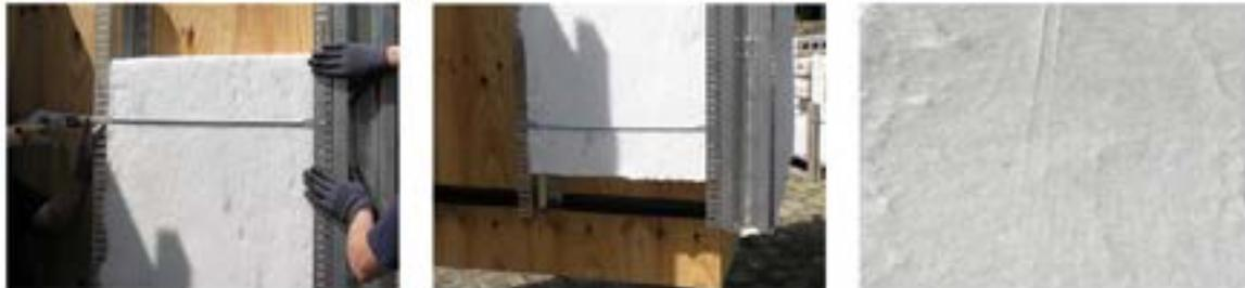
Abbildung 5: Fotos der Konstruktion bestehend aus Dämmelement, Stahlprofil und vorgekrümmtes Klemmprofil. Abbildung: KIT.
