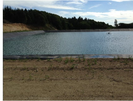
Fotos: Dronninglund Fjernvarme
