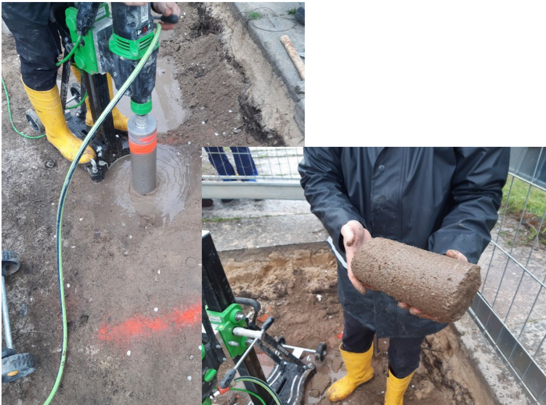
Entnahme von Probekörpern mittels Kernbohrgerät an Aufgrabungen KMR in ZFSV-Bettung in Zusammenarbeit mit Lol-Partnern, Quelle: AGFW/OTHR
