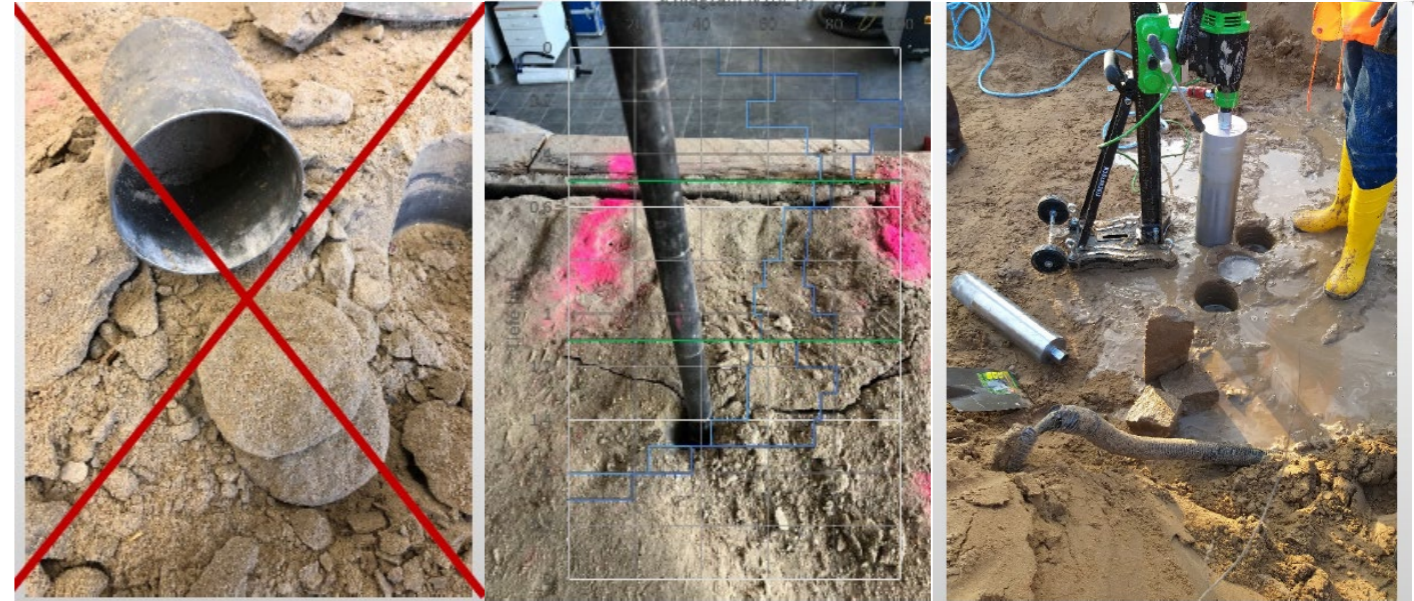
Ausstechzylinder und leichte Rammsondierung ungeeignet als Testmethode zur Bewertung der Wiederaushubfähigkeit bzw. des Langzeitverhaltens ZFSV, Ansatz Entnahme von Probekörpern mittels Kernbohrgerät, Quelle: OTHR
